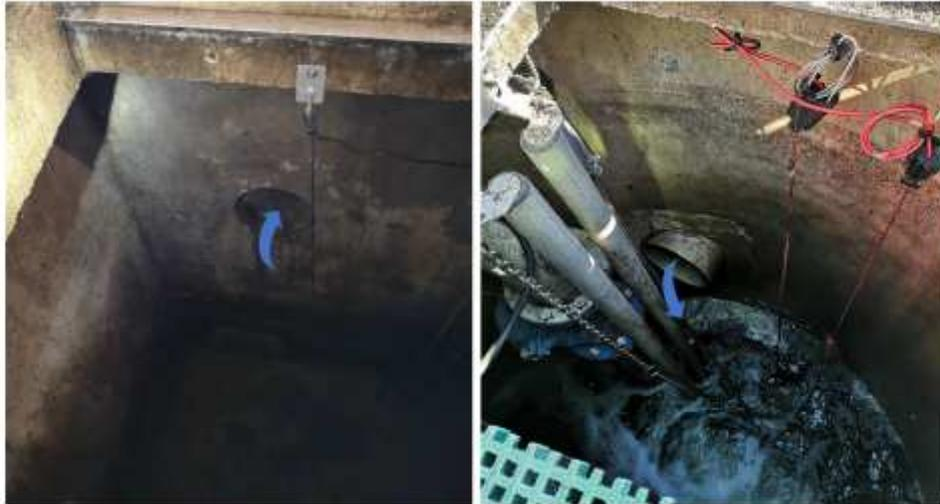
Figure 3-1 : alimentation du trop-plein (à gauche) et rejet (à droite)
